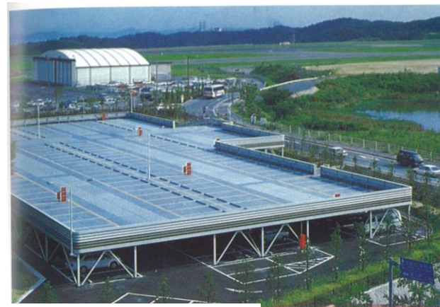
自走式簡易立体駐車場
