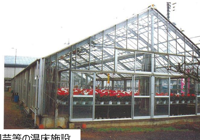
園芸等の温床施設
